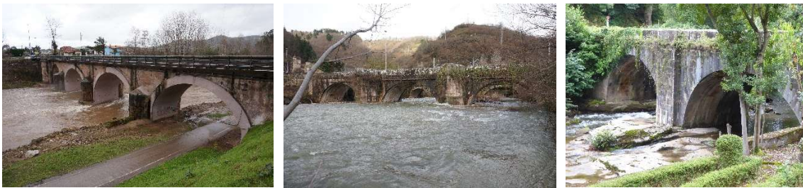
Puentes del Camino Real entre Santander y Reinosa (1748-1753): de Cartes (reconstruido después de la Guerra Civil), de Las Fraguas y de Santa Olalla (LVC).
